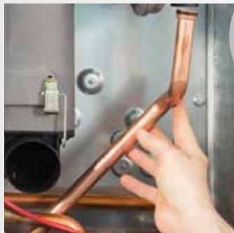
Eliminación del tubo gas
