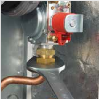
Eliminación del sistema de sierre sobre la válvula gas
