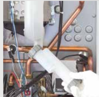
Levantamiento sifón del condensado
