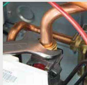
Eliminación del sistema de sierra a la tubería
