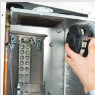
Eliminación del sistema de combustión completo
