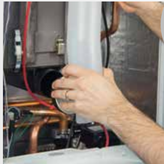
Eliminación del colector de humos
