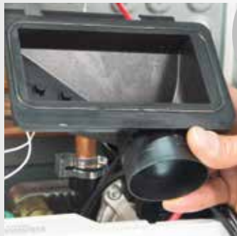
Inspección bandeja de recogida condensado
